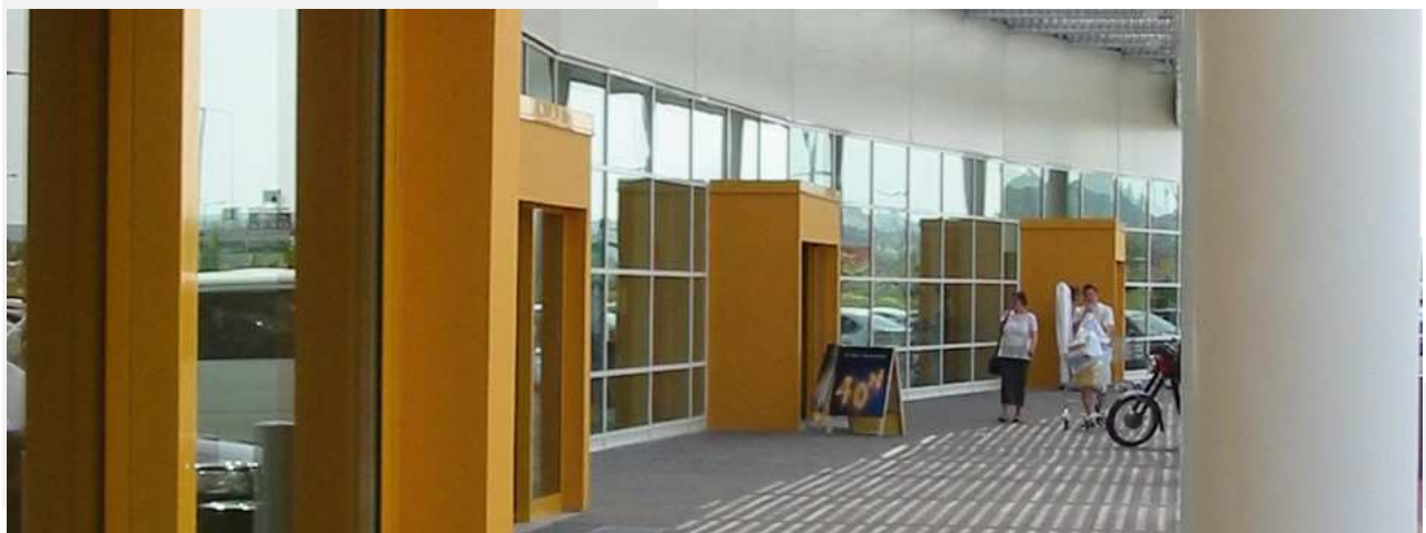
Budaörs Airport Retail Park szárazépítési, festő, burkoló, lakatos munkái
